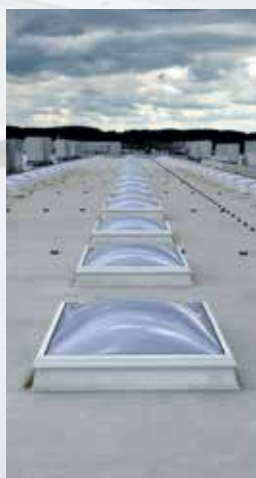
Système CI exutoire de fumées F100
