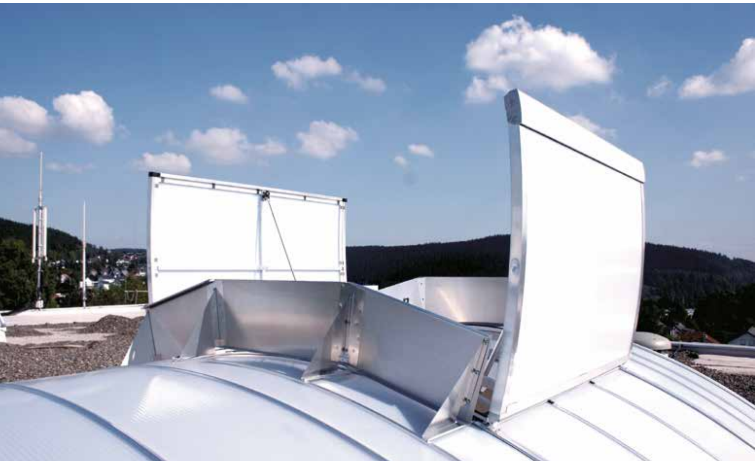
Système à clapets intégré dans le lanterneau continu type B et S du Système CI
