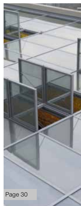
Installations d'évacuation naturelle des fumées et de la chaleur
