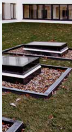
Système CI exutoire de fumées GE F100/FE
